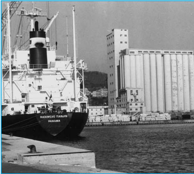
utile di 10,5 metri. I silos sono serviti da 5 linee ferroviarie per complessivi 600 metri di lunghezza operativa.
